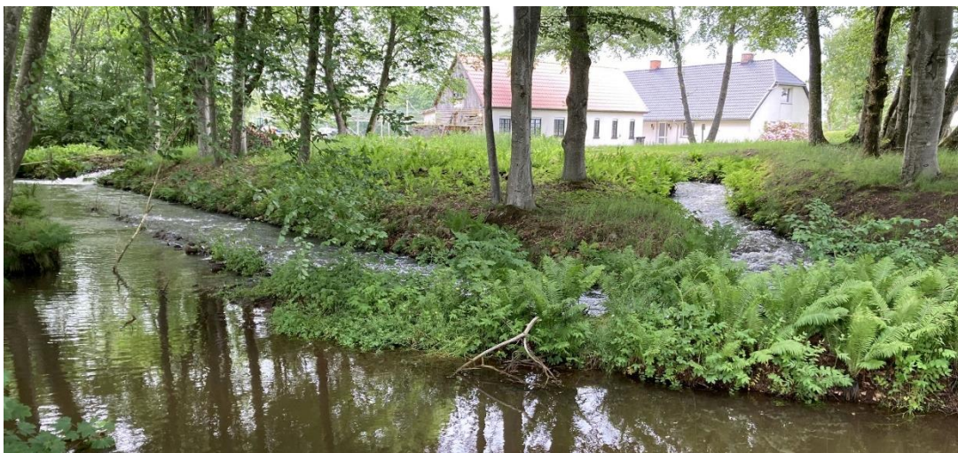
Figur 10. Nuværende omløbsstryg, der møder grøften (Nordeststrømmen), der løber under Åvænget (Bilag 3). Længst til venstre i billedet ses vand fra overfaldskanten, der møder omløbsstryget.
