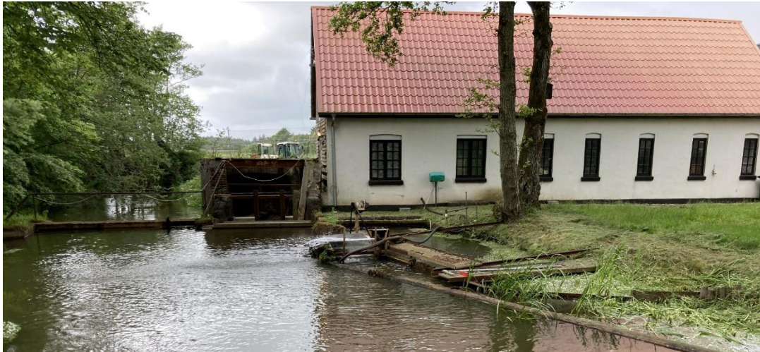
Figur 6. Møllesø og nuværende vandindtag til Tim Mølle Dambrug. Den nuværende faunapassage/omløbsstryg er umiddelbart til venstre for billedet.
